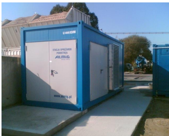
Kontener 20 stopowy z zabudowaną sprężarką Belt 75 Belt 38 w 20 stopowym kontenerze
